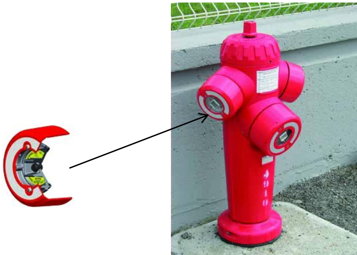
(Exemple de système de décompression avant ouverture)
